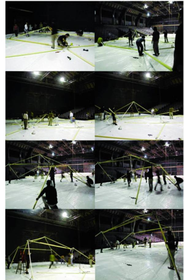
Fig. 121 Proceso de instalación de la Media House (V.Guallart, Mercat de les flors, 2002)
